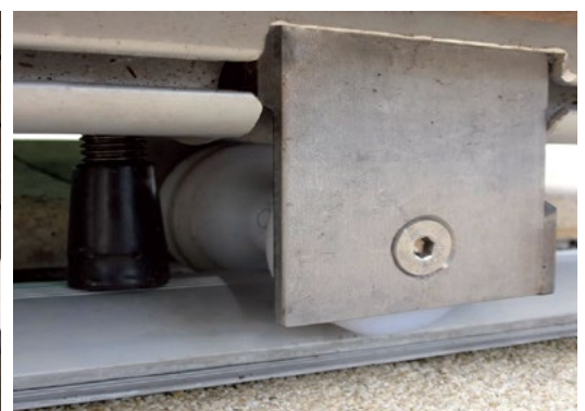
Frein à patin caoutchouc et roue de guidage
