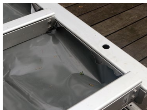
Membrane de propreté positionnée sous l'habillage limitant l'évaporation
