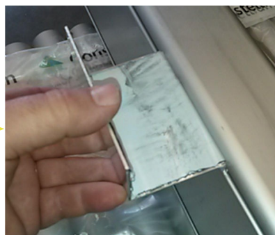
Winkel einführen und nach unten drehen
